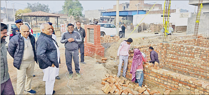
हिसार। लाइब्रेरी के निर्माण कार्यों का निरीक्षण करते कैबिनेट मंत्री रणबीर सिंह गंगवा।
